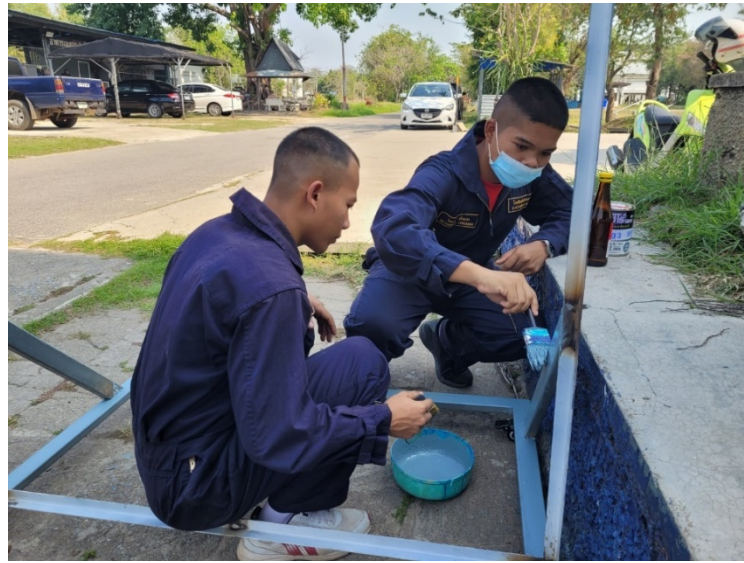
รูปที่ 3.7 ทาสีโครงเหล็ก
