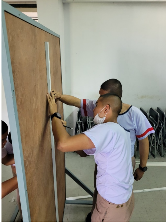
รูปที่ 3.13 ยึดไม้อัดเข้ากับโครงเหล็ก
