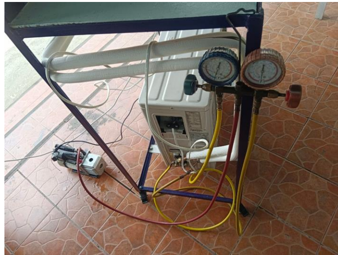
รูปที่ 3.12 การทำสุญญากาศ
