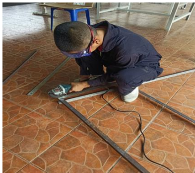
ภาพที่ 2 การเชื่อมฐานโครงสร้าง
