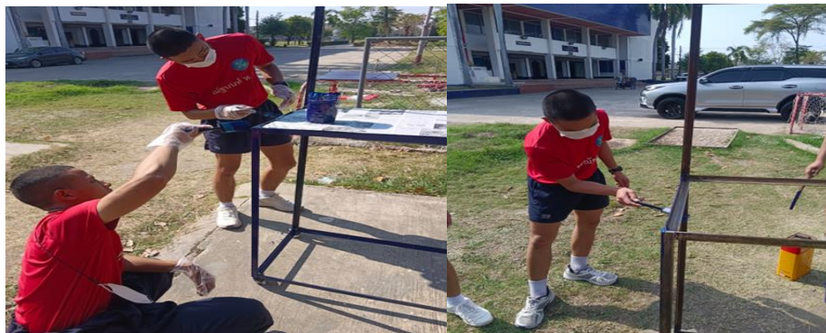
ภาพที่ 6 การทาสีโครงเหล็ก
