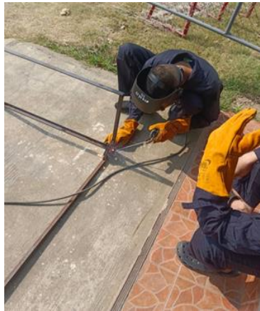
ภาพที่ 2 การเชื่อมฐานโครงสร้าง
