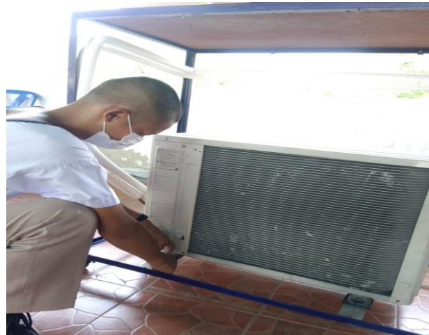
รูปที่ 3.8 ติดตั้งชุดคอยล์ร้อน
