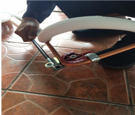
รูปที่ 3.9 การตัดและต่อท่อทองแดง
