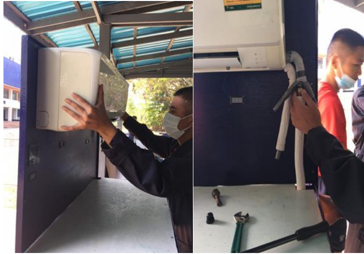
ภาพที่ 7 การติดตั้งอุปกรณ์ต่างๆ ต่อท่อทองแดง
