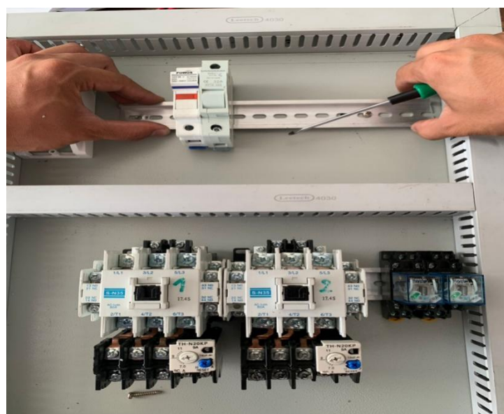
รูปที่ 3.5 ประกอบอุปกรณ์
