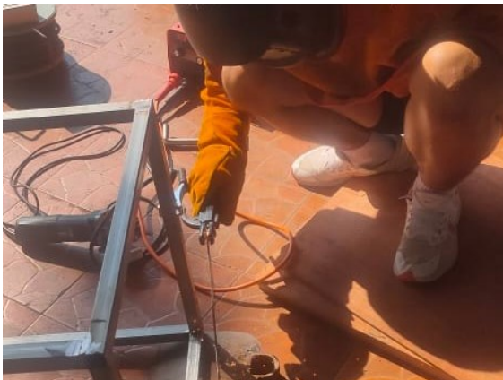
รูปที่ 3.7 การเชื่อมถังเก็บน้ำ
