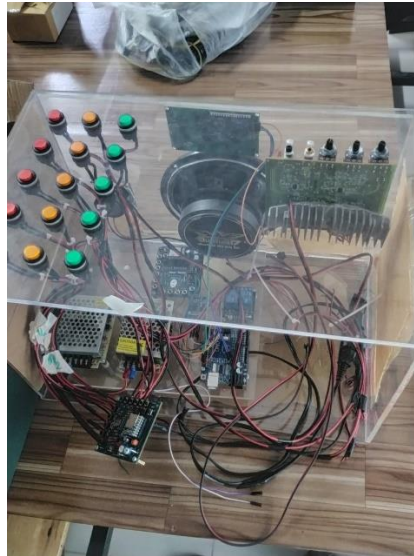
รูปภาพที่ 3.3 ติดตั้งอุปกรณ์ในโครงสร้าง
