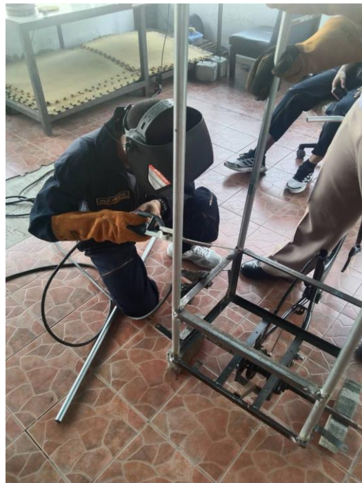
รูปเก็บรายละเอียดหลังการเชื่อมโครงสร้างชิ้นงาน
