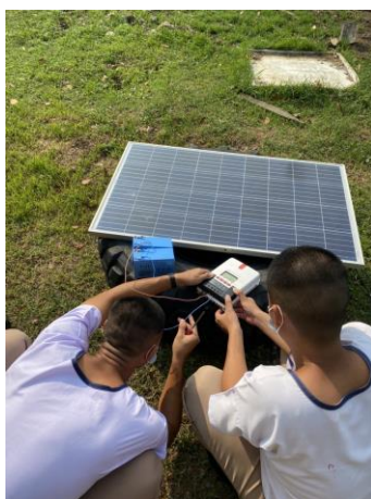
รูปที่ 3.3 ทดสอบการชาร์จแบตเตอรี่จากแผงโซลาร์เซลล์
