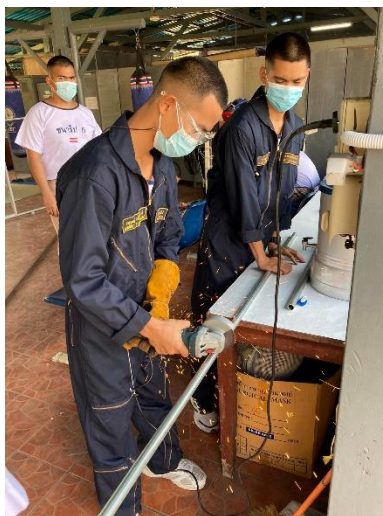
รูปที่ 3.4 ตัดเหล็กเพื่อนำไปใช้เป็นเสาเหล็ก
