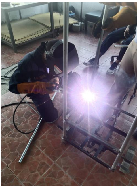
รูปที่ 3.6 ใส่โครงเสาเหล็กที่เหลือ แล้วทำการเชื่อมเข้าด้วยกัน
