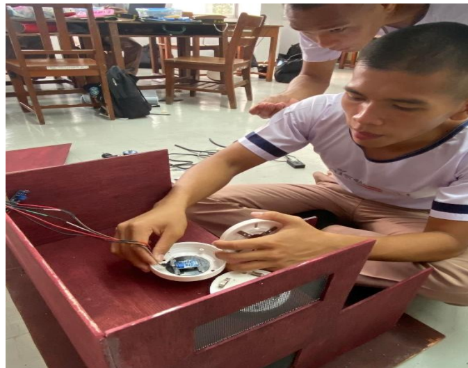
รูปภาคผนวก ข ที่ 8 ติดตั้งระบบและประกอบบ้านจำลอง
