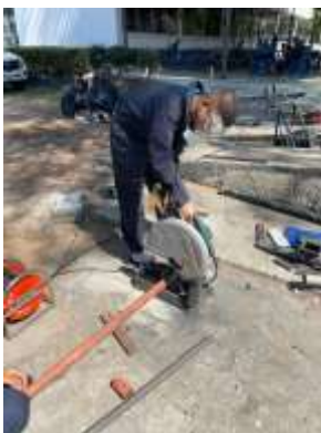
รูปที่ 3.7.1 ตัดเหล็กซ่อมขาเก้าอี้
