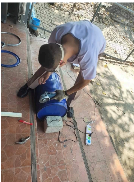
ภาพที่ 3. เจาะช่องอากาศด้านล่างของถัง 60 ลิตร
