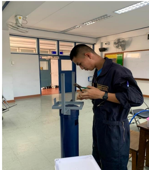
ติดตั้งอุปกรณ์
