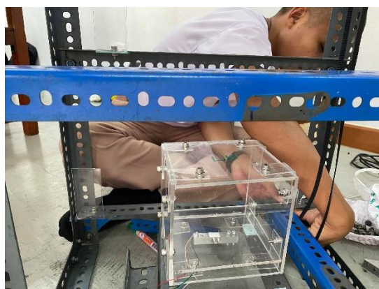
ภาพที่ 8 การติดตั้งกล่องลิฟต์เข้าใน โครงสร้างตัวลิฟต์
