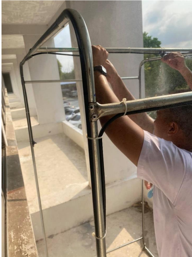
เดินสายน้ำพร้อมติดตั้งหัวพ่นหมอก
