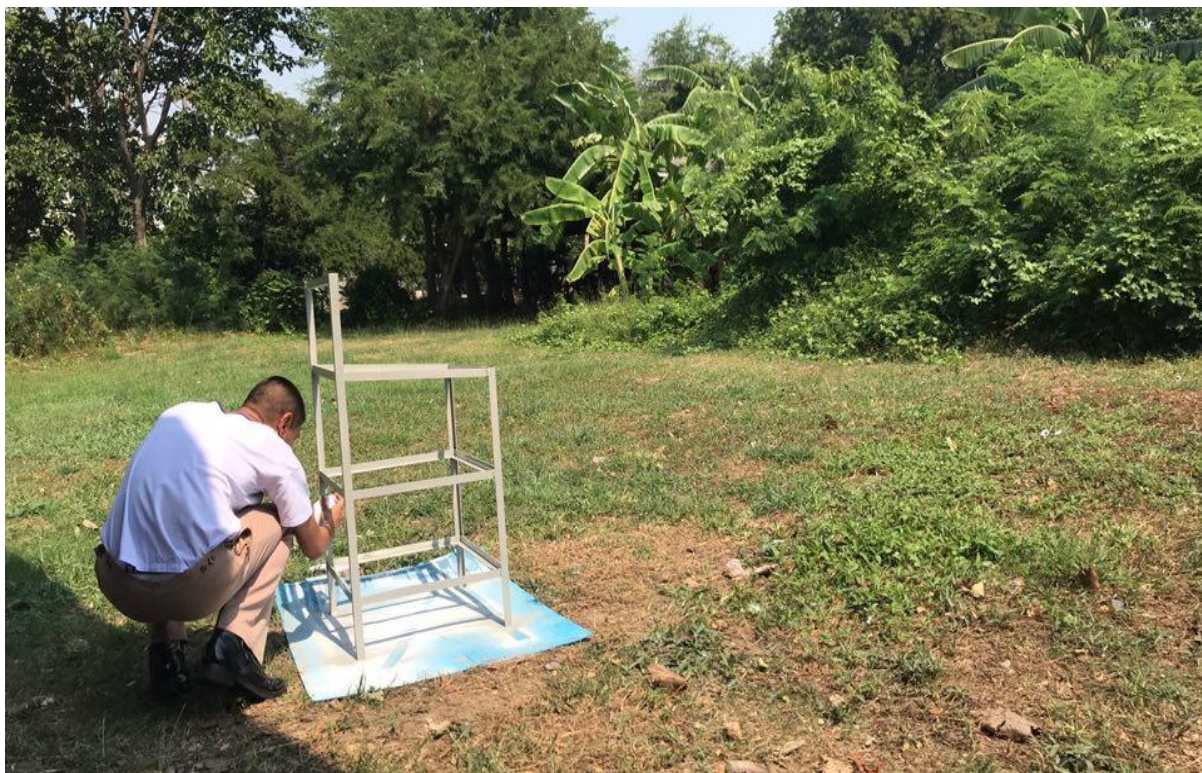
ทำโครงเหล็ก
