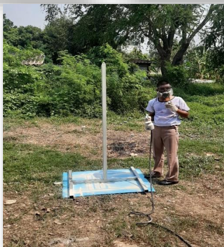
รูปที่ 3.12 ตัดเหล็ก เชื่อมเหล็กและพ่นสีเพื่อทำขั้วแผงโซลาเซลล์
