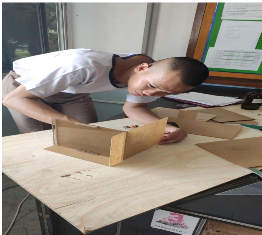
รูปที่ 3.13 ประกอบโครงสร้าง
