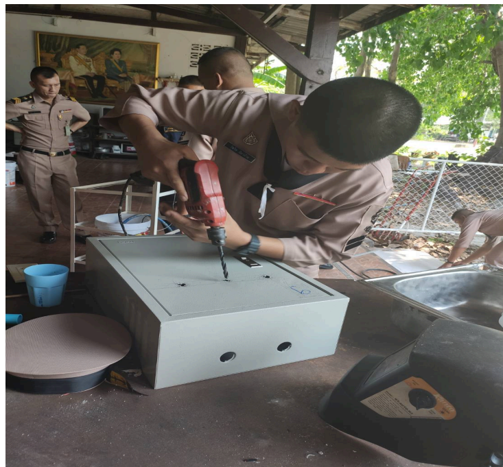
รูปที่ จ - 2 เจาะรูและตัดตามขนาดที่กำหนด
