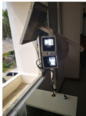
(ข) ไฟติดสามารถใช้งานได้
