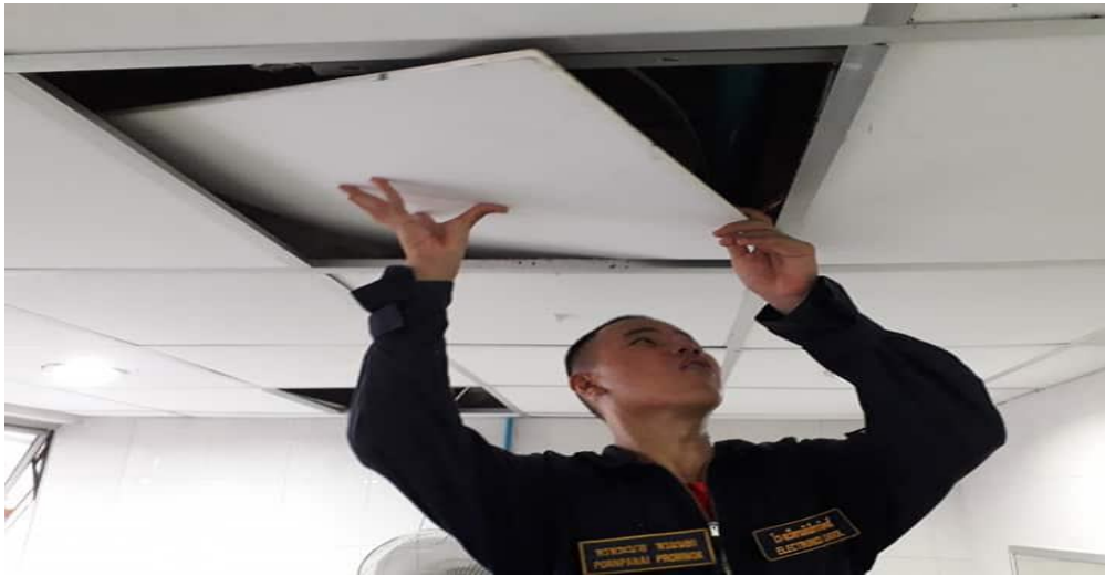
รูปที่ 3.3.9 ทำการติดตั้ง
