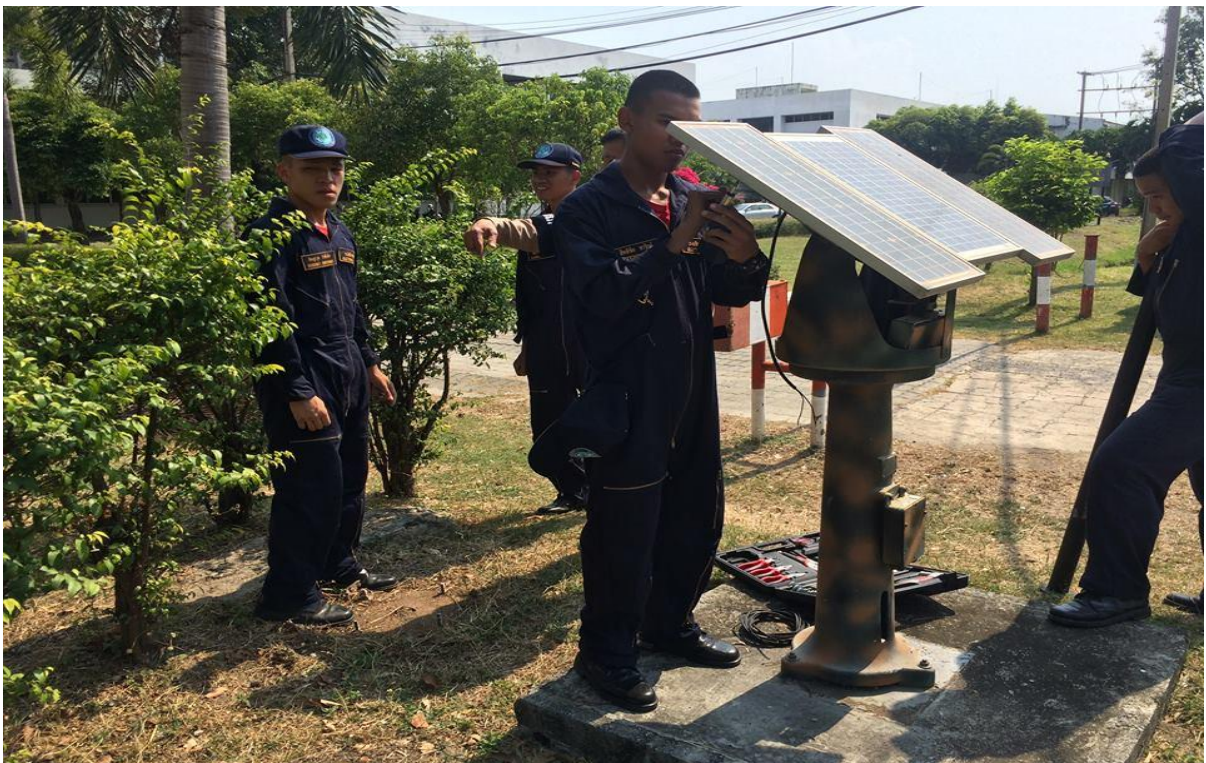
รูปที่ 3.6 จัดทำติดตั้งไฟสปอร์ตไลท์และแผงโซลาร์เซลล์
