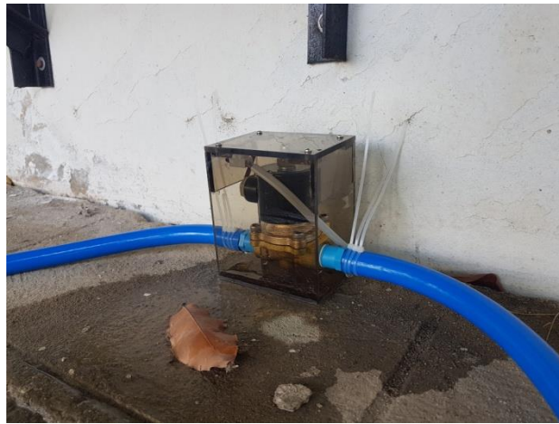
รูปที่ 3.8 ติดตั้งกล่องควบคุมประกอบโซลินอยด์ที่ต่อกับท่อน้ำ
