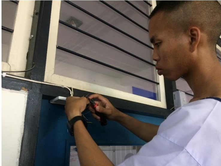
รูปที่ 4.1.2.6 ติดตั้งเซนเซอร์อินฟาเรด
