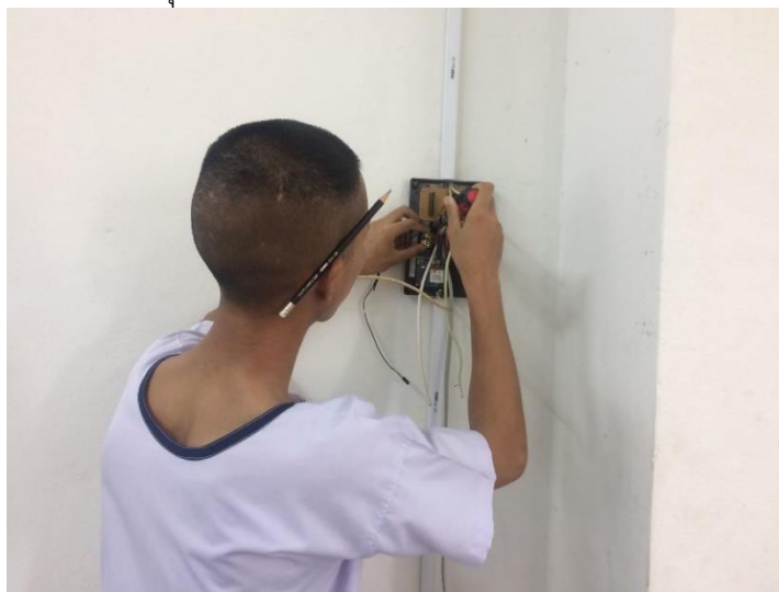
รูปที่ 4.1.2.4 ติดตั้งและประกอบกล่องควบคุม
