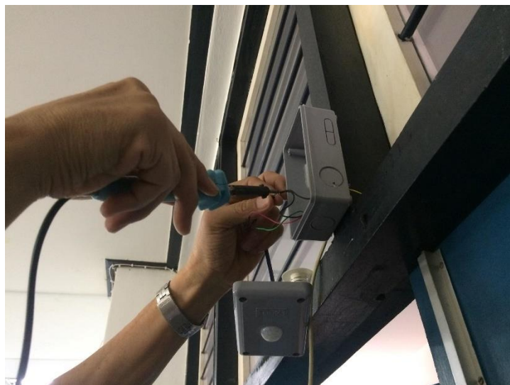
รูปที่ 4.1.2.7 ติดตั้งเซนเซอร์ตรวจจับความเคลื่อนไหว
