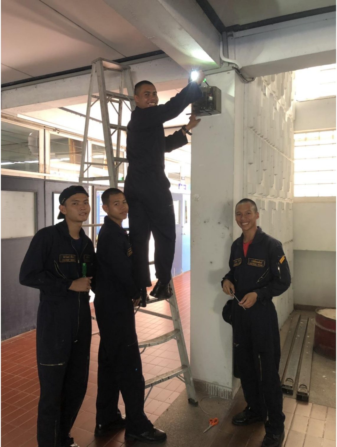
ทำการติดตั้งไฟฟ้าฉุกเฉิน
